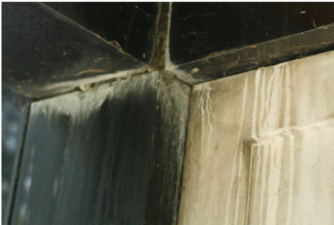
Stav před opravou rozestoupené kvádry, černé krusty a jiné depozity, bílé výkvěty.
