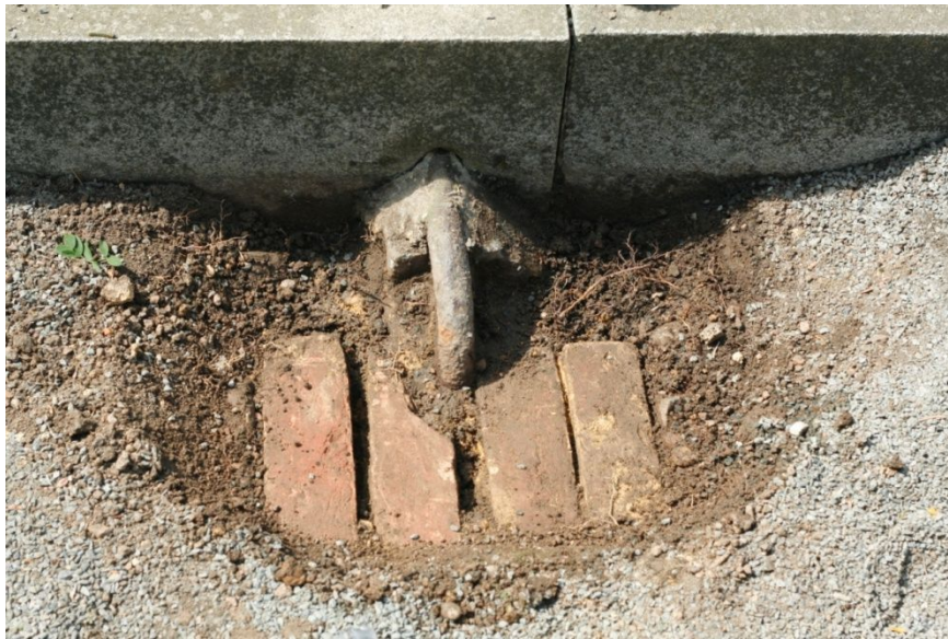
Sonda pod terénem. Detail kovové trubky procházející žulovým soklem.
