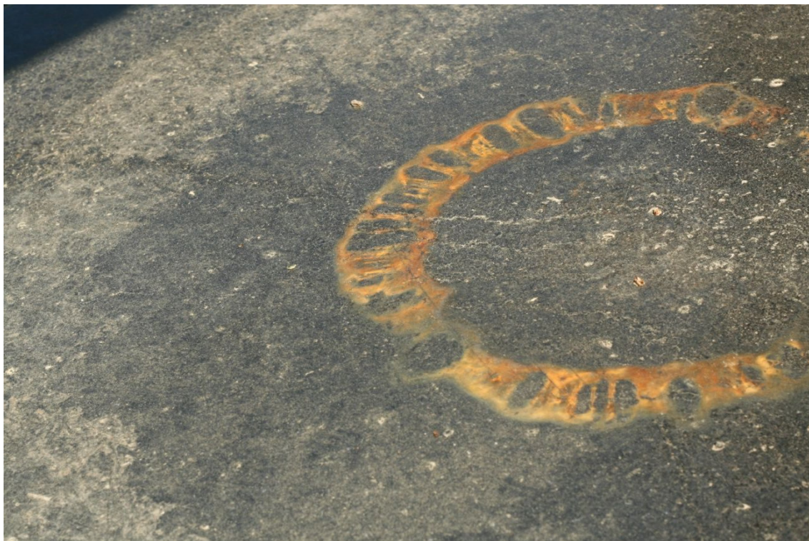
Detail poškození kamenné desky (koroze železného drátu věnce).
