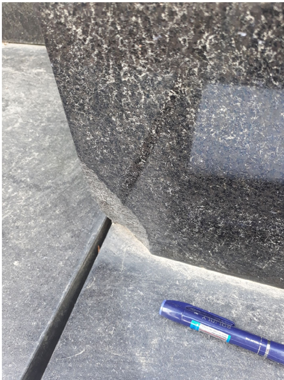
Množství mechanicky poškozených hran noritu (švédské žuly). Postranní rámy se rozbíhají.
