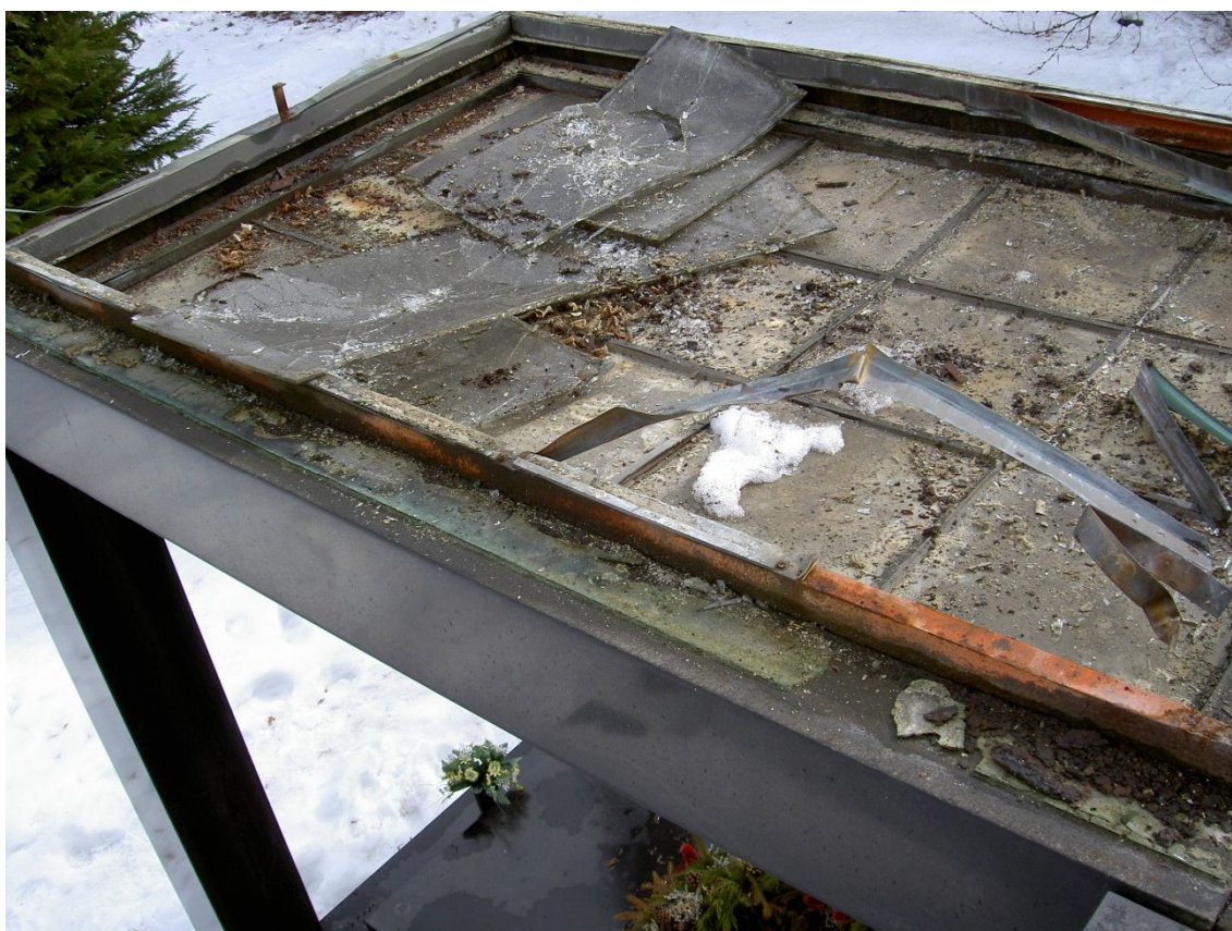
Detail poškození střechy. Rozbité skleněné výplně, odcizené kovové konstrukce.
