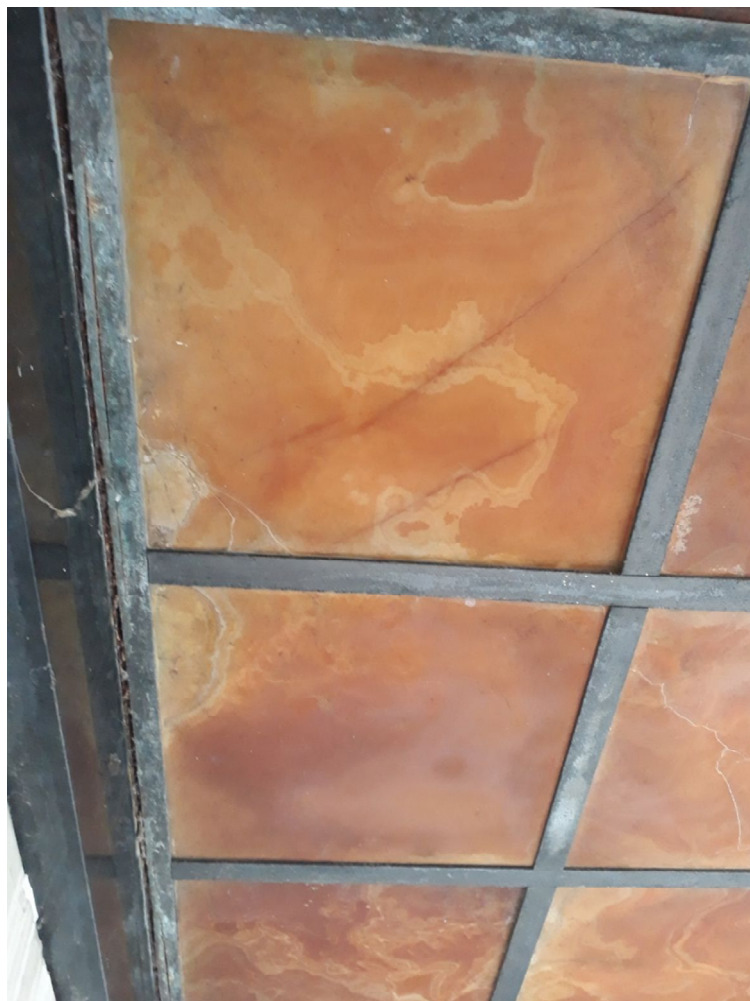
Zašlé a poškozené světlo propouštějící onyxové desky.
