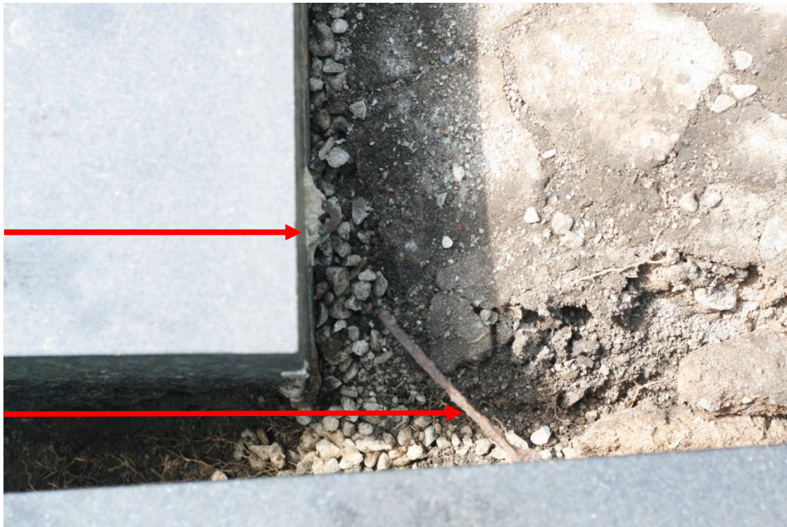
Sonda. Detail uvolněné jistící kotvy a posunutý kvádr černého noritu lemující půdorys hrobky. Pod štěrkem je cementová skořepina a hlína.
