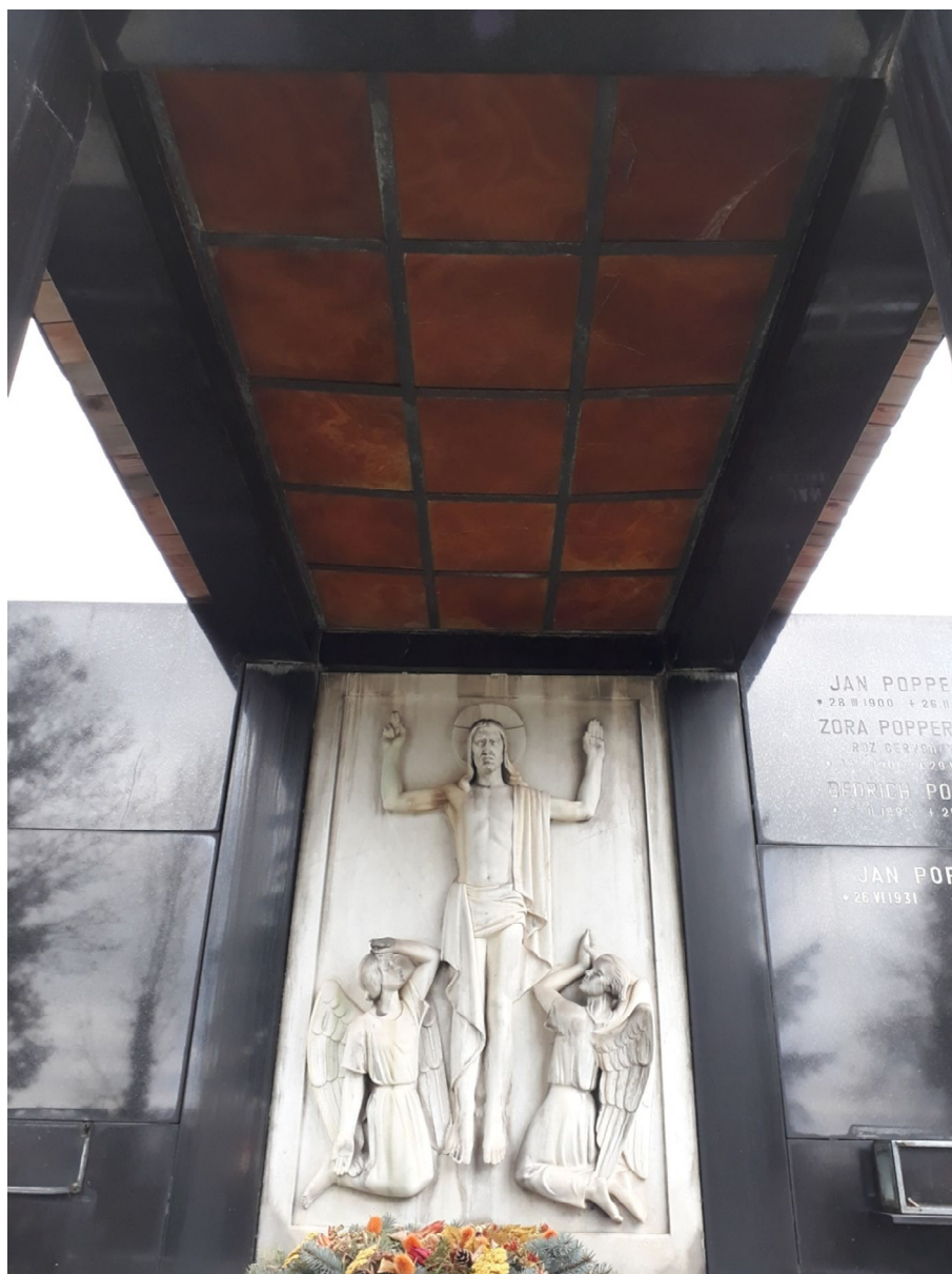
Celkový pohled. Stav před opravou. Podhled zašlého onyxového stropu.
