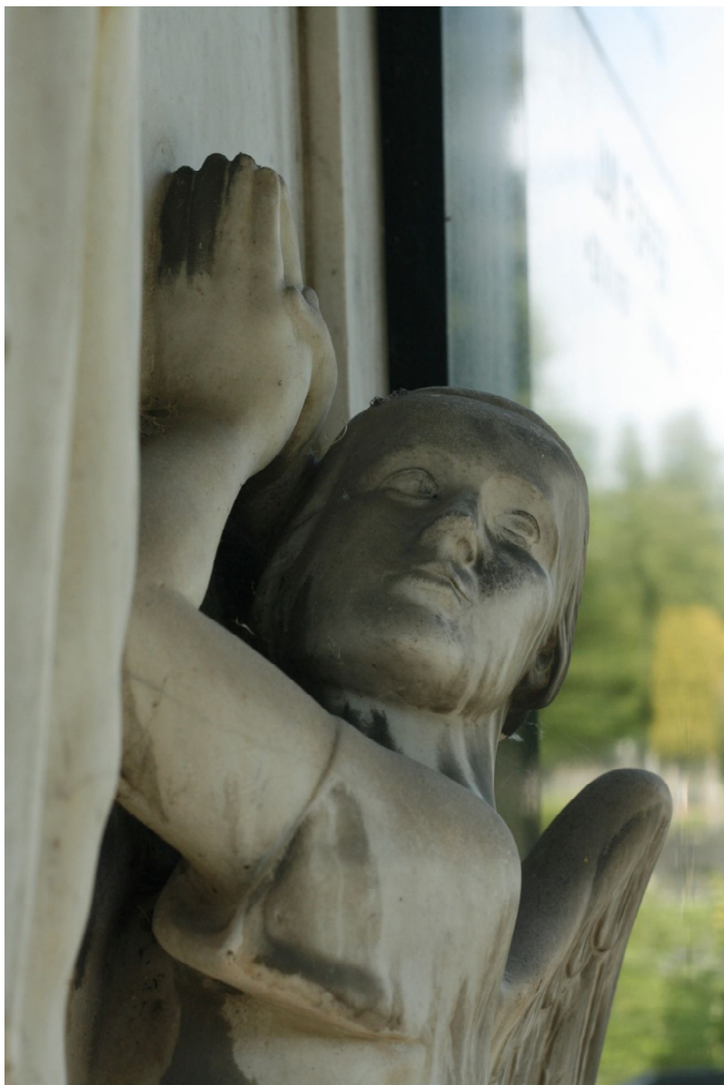
Detail reliéfu. Depozity a černé krusty ve srážkovém stínu.
